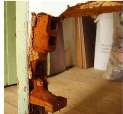
Figura 3.12 – Parede divisória em tijolo de burro.
