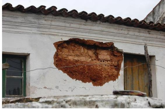
Figura 3.10 – Constituição da parede da fachada principal.
